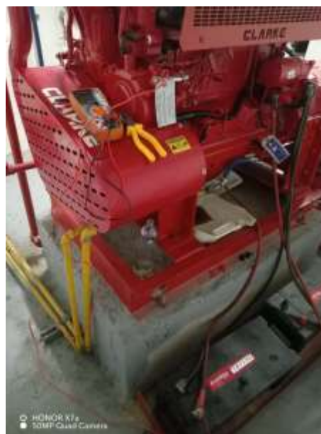
Figura 11. Pruebas independientes en solenoide.
