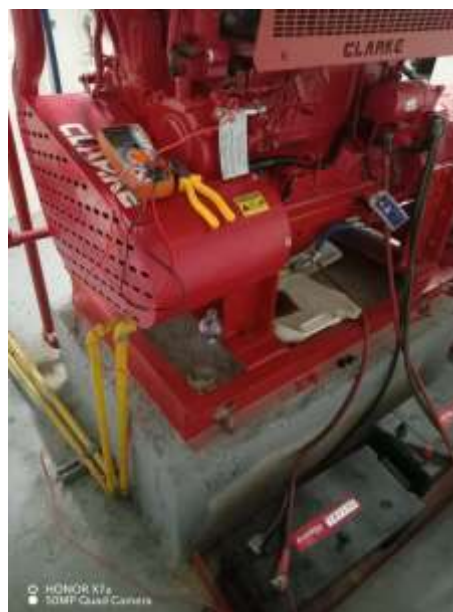
Figura 11. Pruebas independientes en solenoide.
